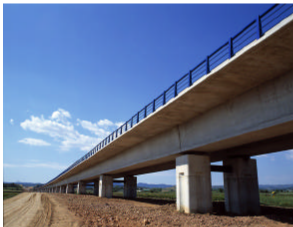
Fig 2 Viaducto de la LAV Madrid-Barcelona en Montblanc (viaducto de vanos isostáticos)
