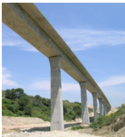
Fig 1 Viaducto de la LAV Madrid-Barcelona en Sant Sadurn d'Anoia (viaducto continuo)
