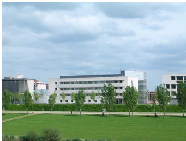
Llera del riu transitable. Costat Campus Universitari
